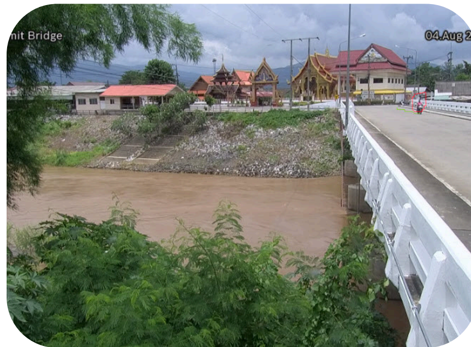
สะพานประชานิยมิต อ.แม่ริม จ.เชียงใหม่
